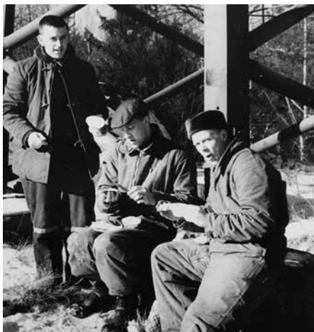
Börje (i mitten) bygger flygfyrar för flygvarvet.
