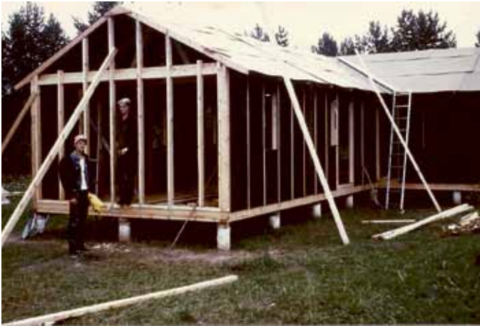
Stora huset under uppförande, Imnäs 1979.
